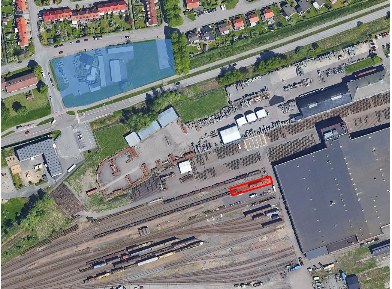
Figur 10. Tvättning och tömning av gasfas från tankvagnar som tidigare innehållit diesel eller motsvarande sker på för ändamålet avsedd plats (röd markering).
